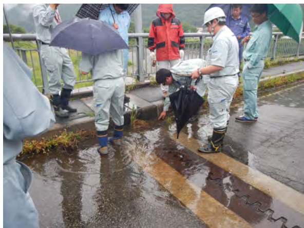
南会津管内 橋梁視察状況 3 (ジョイント部における劣化の誘因になる水たまりの発見, 排水口の詰まりを除去)
